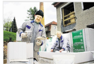
Nachdem die Bodenplatte gegossen wurde, setzen Maurer Volkmars Gube (vorn) und Vorarbeiter Bodo Grabowski die ersten Steine des neuen Treppenhauses an der Turnhalle in Langenwolmsdorf. Fotos: Matthias Haßpacher
